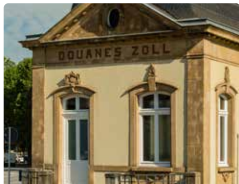
Pavillon douanier néo-baroque à côté du pont
