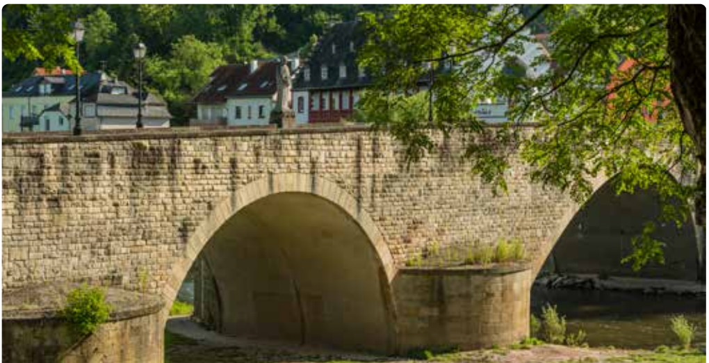
Grensbrug over de Sauer tussen Luxemburg en Duitsland
