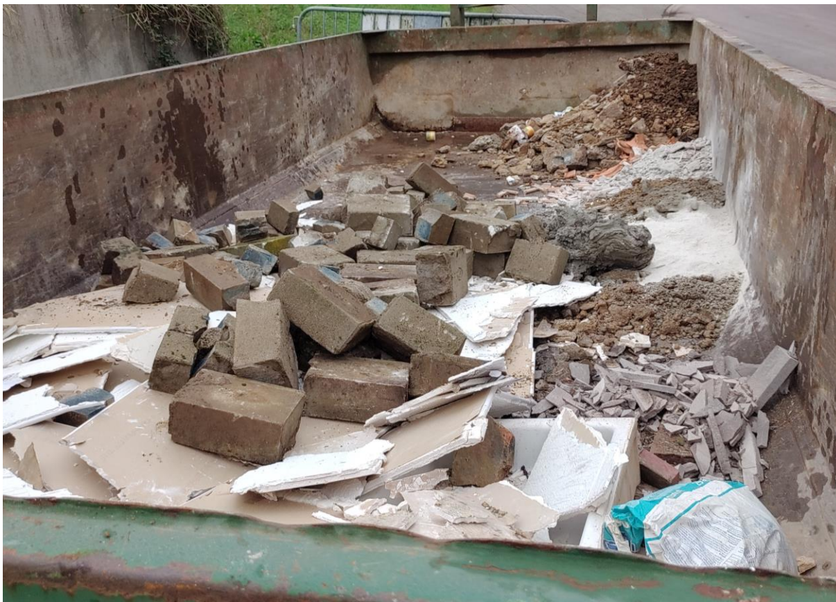
Abbildung 19: Bauschuttcontainer mit Fehlwurf (Gipsplatte).
