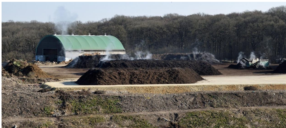
Abbildung 9: Kompostierungsanlage am Standort Muertendall. (sigre.lu)
