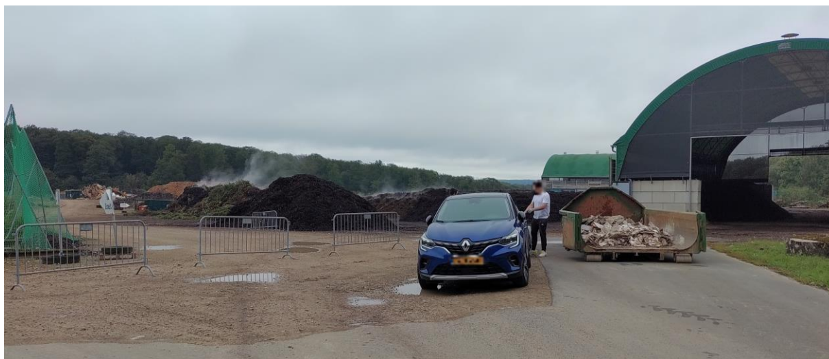
Abbildung 12: Sammelstelle für Bauschutt. (23.09.2023)
